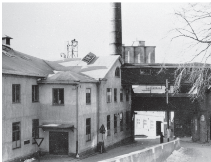
"Strumpans" fabrik 1930-tal, före ombyggnad.
